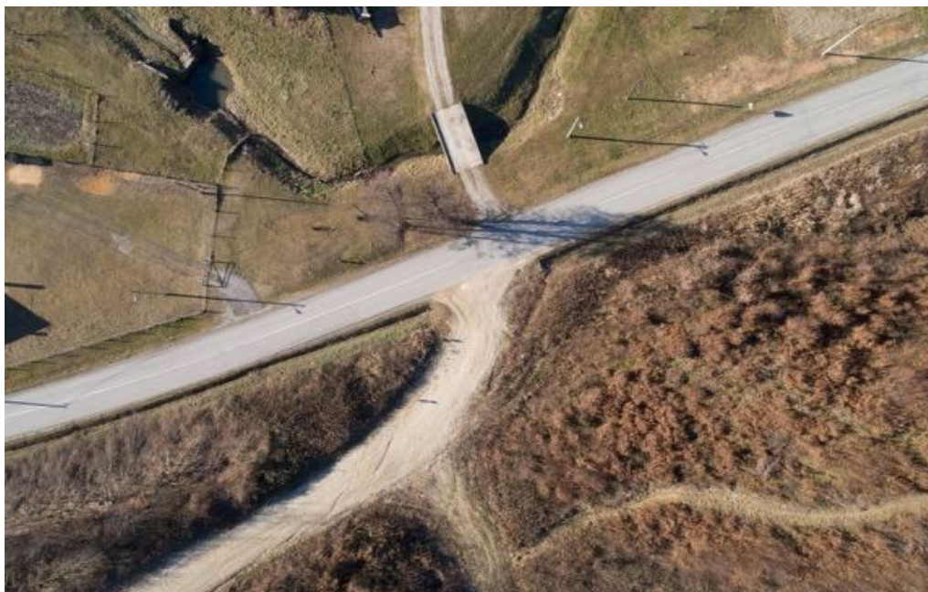
Slika 165 - Spoj glavne prometnice i makadamskih staza na području Jagljedovca (Autori: Agronomski fakultet i 3E PROJEKTI d.o.o.)
