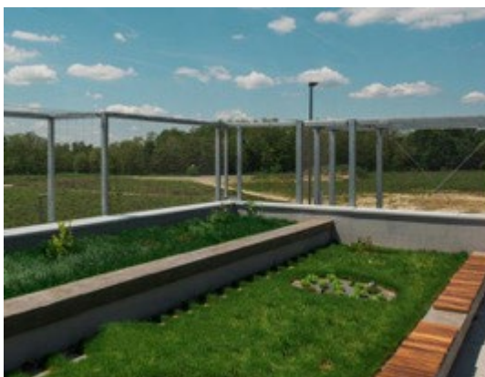
Slika 240 Referentni primjer krovnog vrta (Izvor: Tehno park Garešnica, 3E PROJEKTI d.o.o.)
