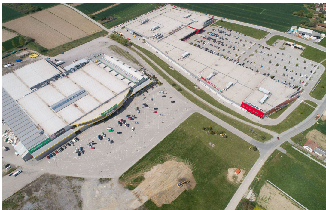
Slika 158 - Parking u sklopu trgovačkih centara Pevex, Interspar i SuperNova (Autori: Agronomski fakultet i 3E PROJEKTI d.o.o.)
