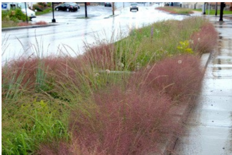
Slika 216 Kišni vrt uz prometnicu (Izvor: Lancaster+bioretention+claudia+west, Phyto Studio )
