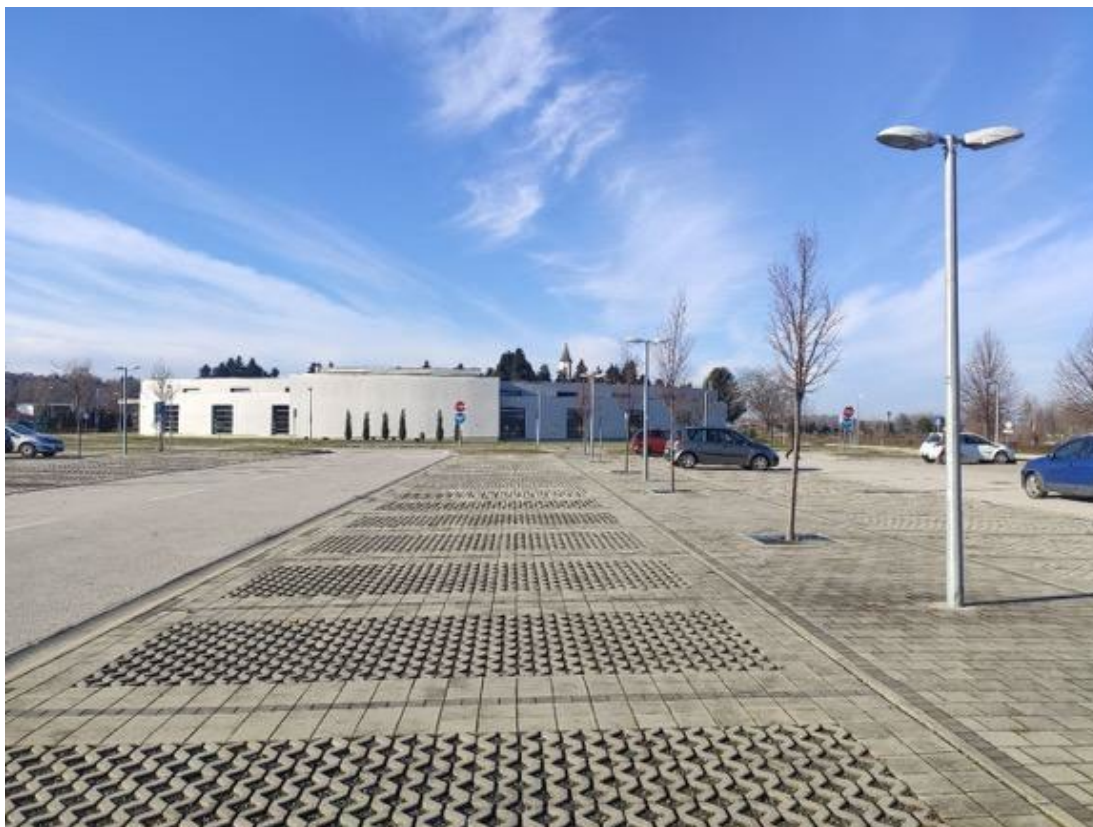
Slika 157 - Parking u sklopu gradskog groblja (Autori: Agronomski fakultet i 3E PROJEKTI d.o.o.)
