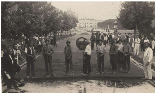
Sl. 3.13. Asfaltiranje Starčevićevog trga, 1911., izvor: MGK
