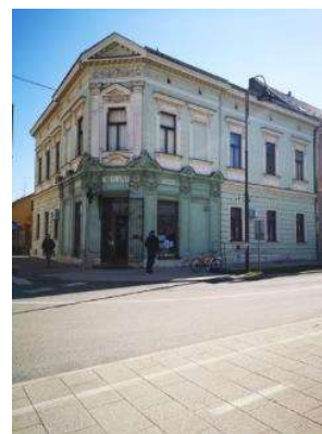
Sl. 4.5.20. Ljekarna K orlu, G. Carnelutti 1906.-07. Ugao Esterove 5 i Frankopanske 2, Koprivnica
