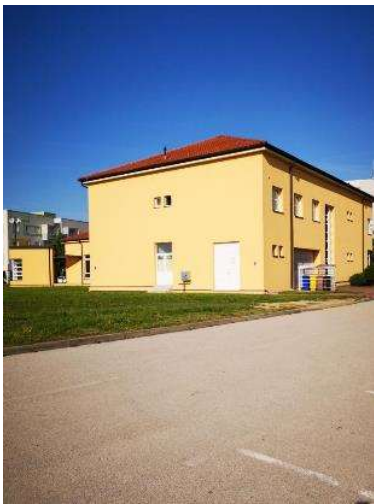
Sl. 4.4.13. Župna crkva Blaženog Alojzija Stepinca, Koprivnica
