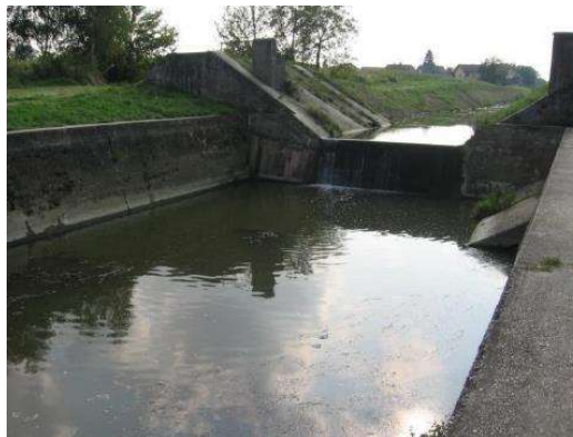
Sl. 4.3.80. Regulacija vodotoka potoka Koprivnica
