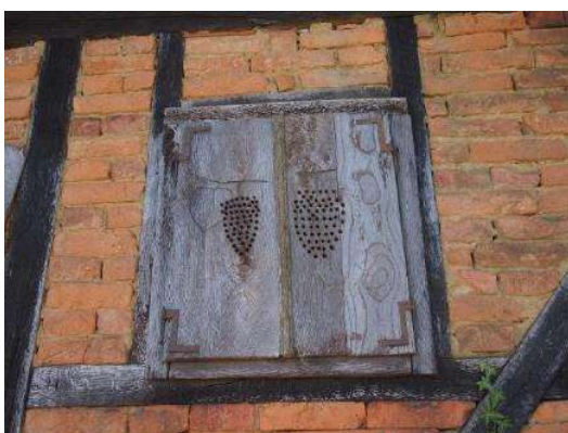
Sl. 4.7.57. Ukraši na priklopima, izrađeni u obliku grozdova na peteljci, Kunovec Breg.
