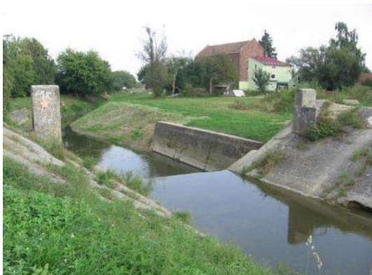
Sl. 4.3.79. Regulacija vodotoka potoka Koprivnica
