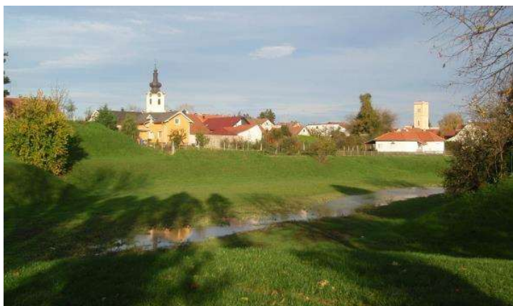
Sl. 4.3.54. Očuvani dio istočne strane renesansne tvrđave (sa opkopima ispunjenim vodom poslije kiše)
