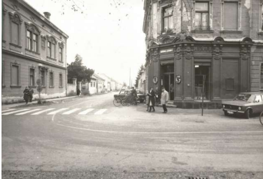
Frankopanska 2 – pogled istok
