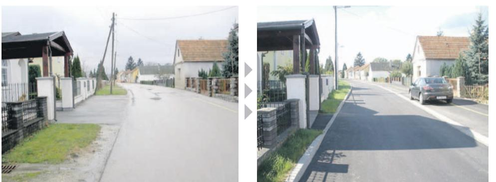
izvođenje kanalizacijskih priključaka, rekonstrukciju vodovodne mreže s priključcima, izgradnju odvodnje oborina s priključcima i distributivne telekomunikacijske kanalizacije te asfaltiranje prometnih površina. Od Starogradske ulice do Ulice I. G. Kovačića, u dužini od 50 m, rekonstruiran je kolnik u širini 6 m za dvosmjeran promet te izgrađena pješačko-biciklistička staza sa sjeverne strane. Nastavni koridor Špoljarske ulice od
