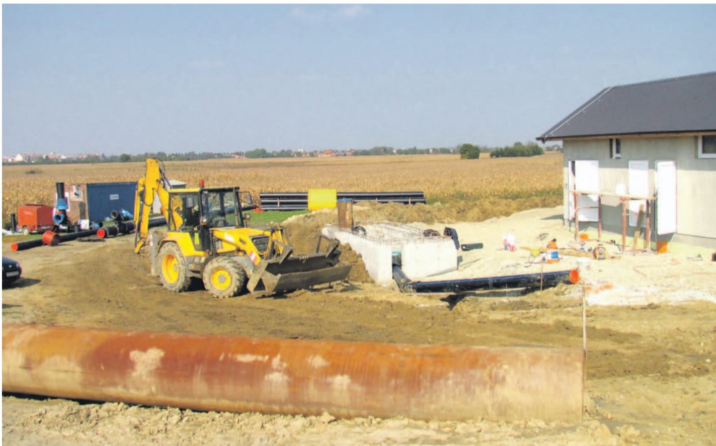
Radovi na novom vodocrpilištu Lipovec
