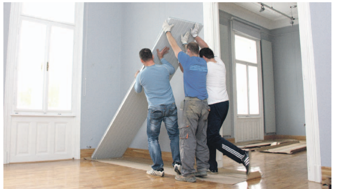
Završetak instalaterskih radova u izložbenom prostoru Galerije Koprivnica
