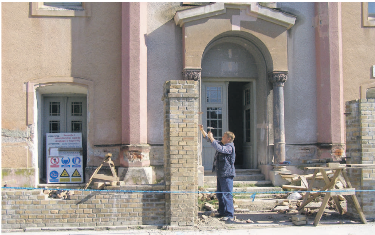
Radovi na Sinagogi
