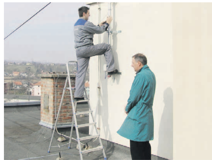
Ugradnja modula za daljinsko očitavanje
