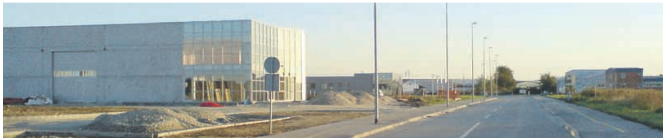
Poslovna zona "Dravska", novo izgrađene hale
