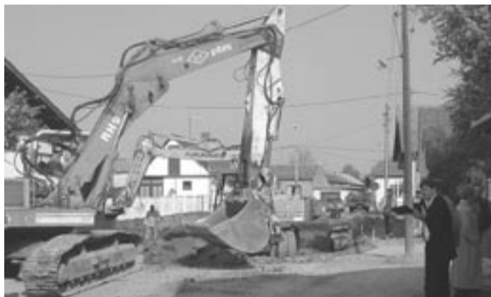
Otvorenje radova u Gibaničnoj ulici
