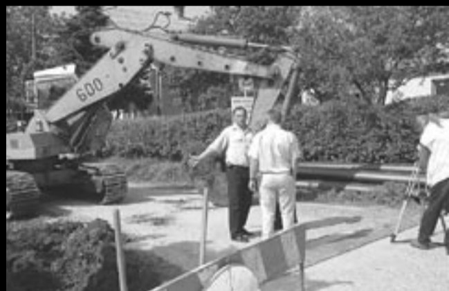
Otvorenje radova na kanalizaciji u Močilama
