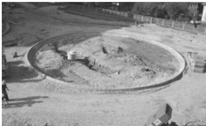
Rotor u izgradnji
