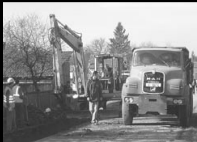
Otvorenje radova na kanalizaciji u Prvomajskoj ulici u Starigradu
